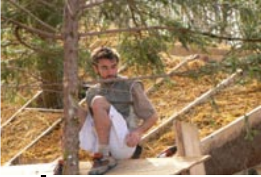
Toiture avec isolation paille/chaux/sciure, traversée d'un arbre vivant
