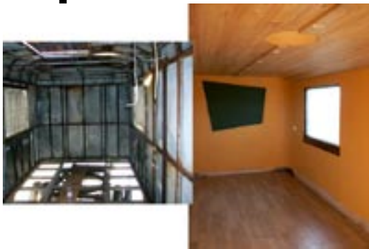
Rénovation d'une roulotte, Cirque Melem, Loudet, Reprise chassis, isolation et aménagement
