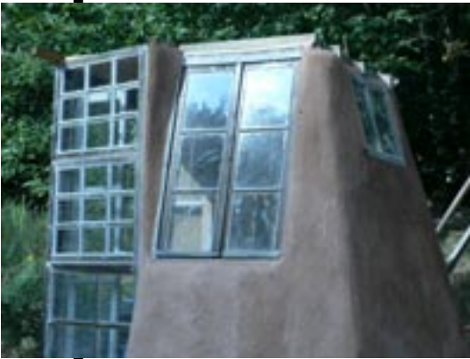
Mur de torchis, enduit chaux, terrain d'Ardheia
