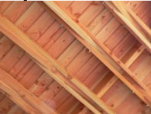
Charpente "ferme chevron" en douglas de la coque de bateau renversée, golfe du Morbihan
