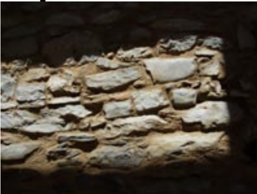
Mur en pierre, chantier chez zouz, St Gaudens
