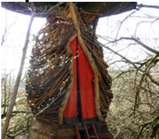
Assemblage de "petits bouts de bois" de diverses essences, toilettes sèches, terrain d'Ardheia
