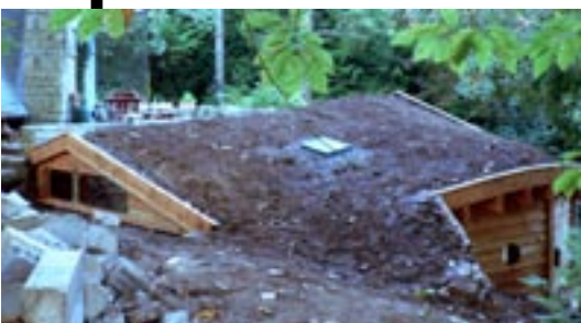
Toiture végétale légère sur isolation liège, golfe du Morbihan
