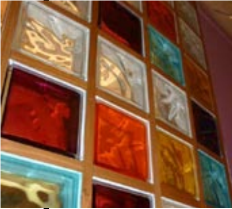
Douglas en menuiserie, Paroi cintrée en bois et briques de verre, Haute Savoie
