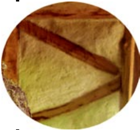
Enduits chaux sur collombages intérieurs, Cabane du crapaud, Terrain d'Artheia
