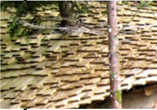
Cabane du crapaud, toit de bardeaux douglas, isolation paille chaux, terrain d'Ardheia
