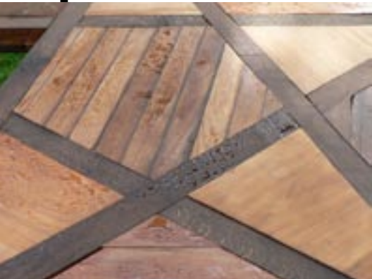
Plancher solivé en étoile, assemblage de bois, terrain d'Ardebia
