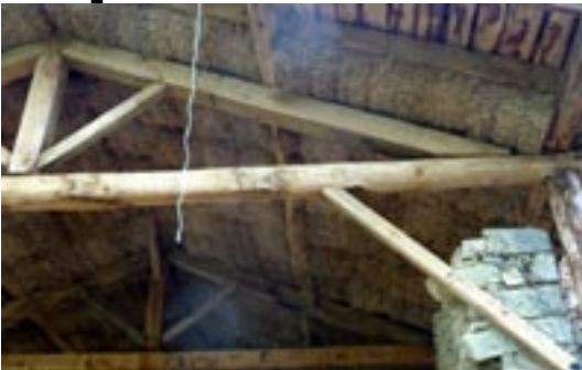
Charpente traditionnelle, isolation botte de paille, chataignier équarri 2 et 4 faces et bois rond, St Gaudens
