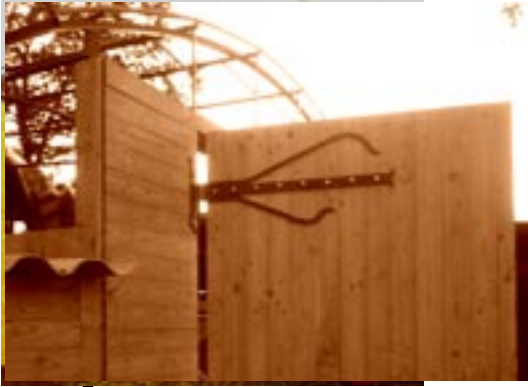
Structure métallique et fer forgé, Cirque Melem, Loudet
